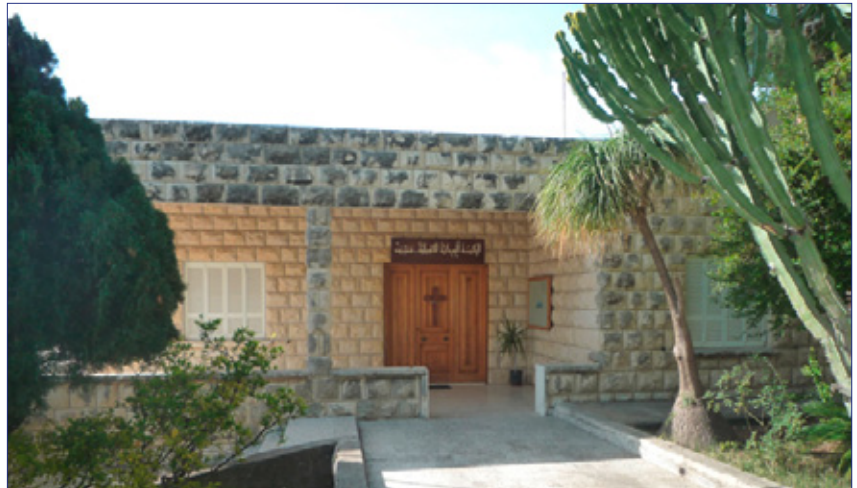
Gemeindegebäude in Amchit
